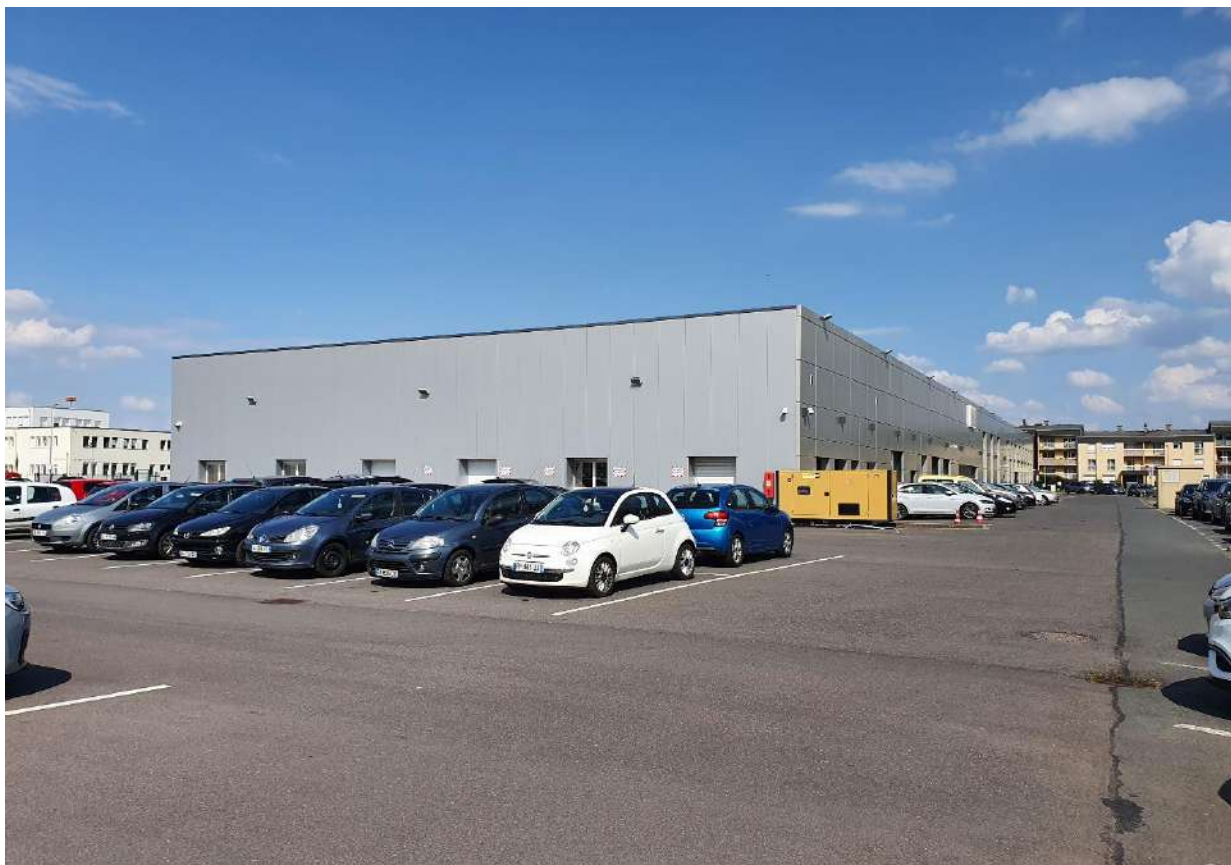
Figure 10: Angle SUD OUEST / Façades + Espaces de stationnement
