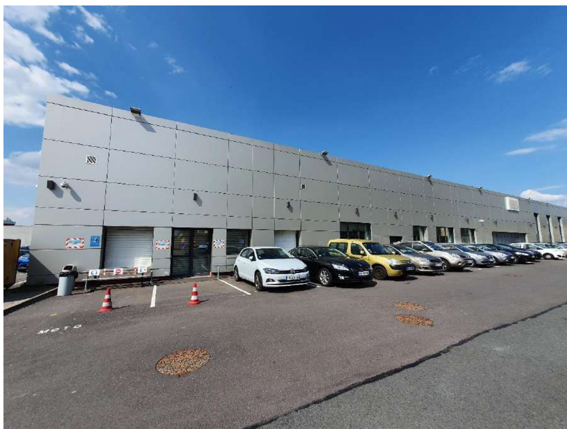
Figure 9: Face SUD / Façade avant + espaces de stationnement
