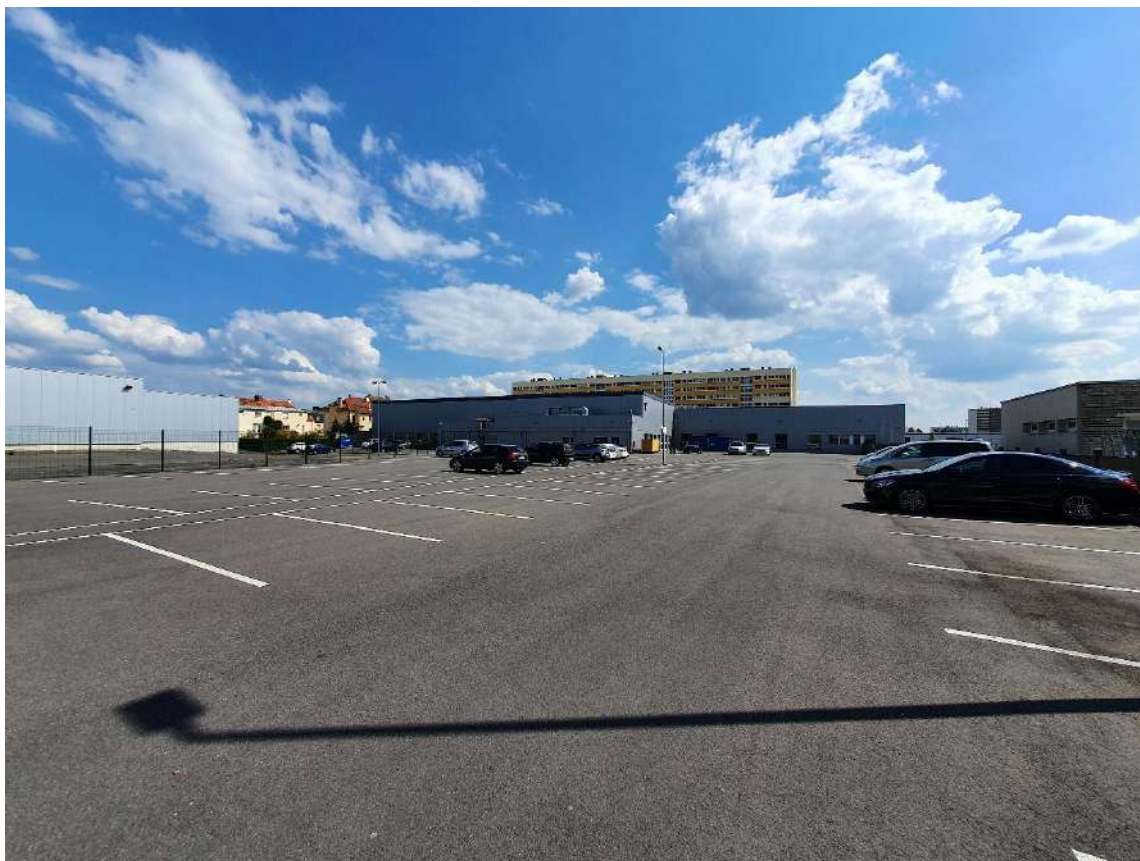
Figure 16: Lots 1, 2 et 3 / Côté NORD / Espaces de stationnement
