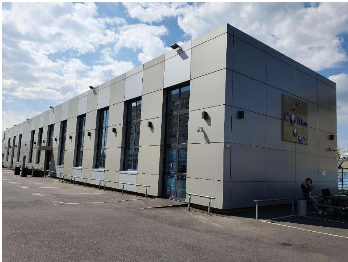
Figure 4: Angle SUD EST / Façade avant + Entrée COMETZ
