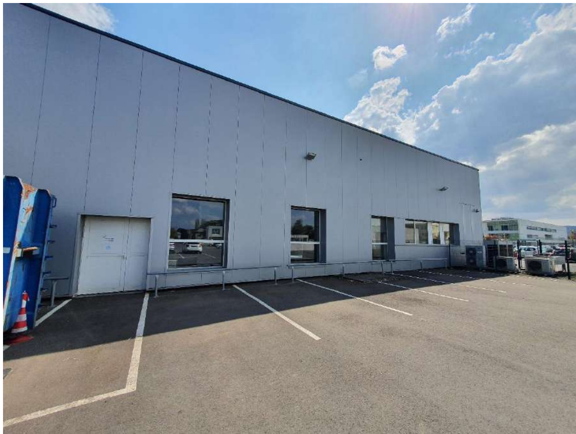
Figure 13: Face NORD / Façade + espaces de stationnement + sortie de secours
