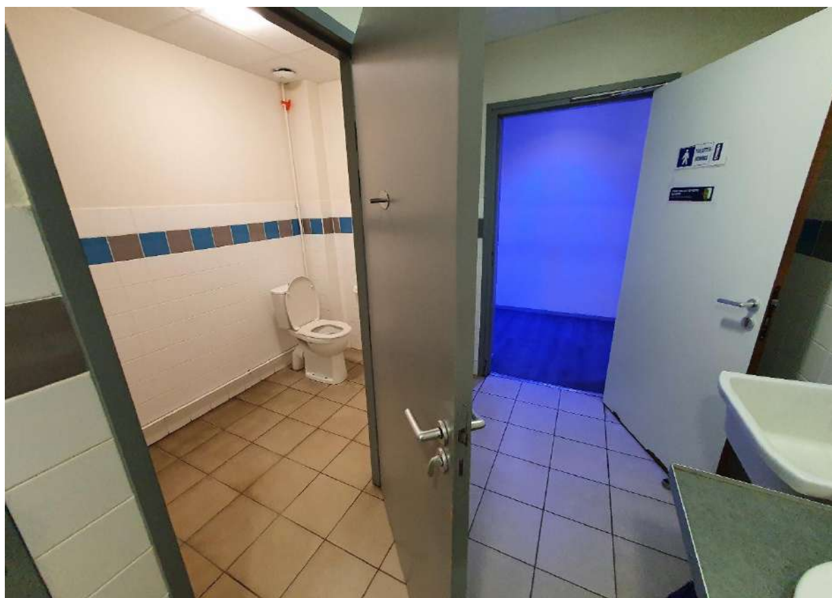
Figure 27: Lot 2 / Partie OUEST / Bloc sanitaires hommes
