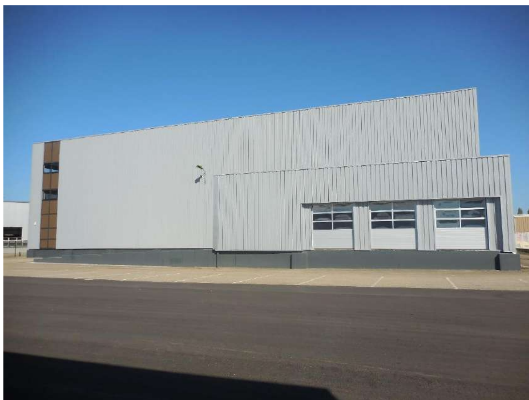
Figure 8: Lot 8 / Accès bureaux et dépôt avec rampe
