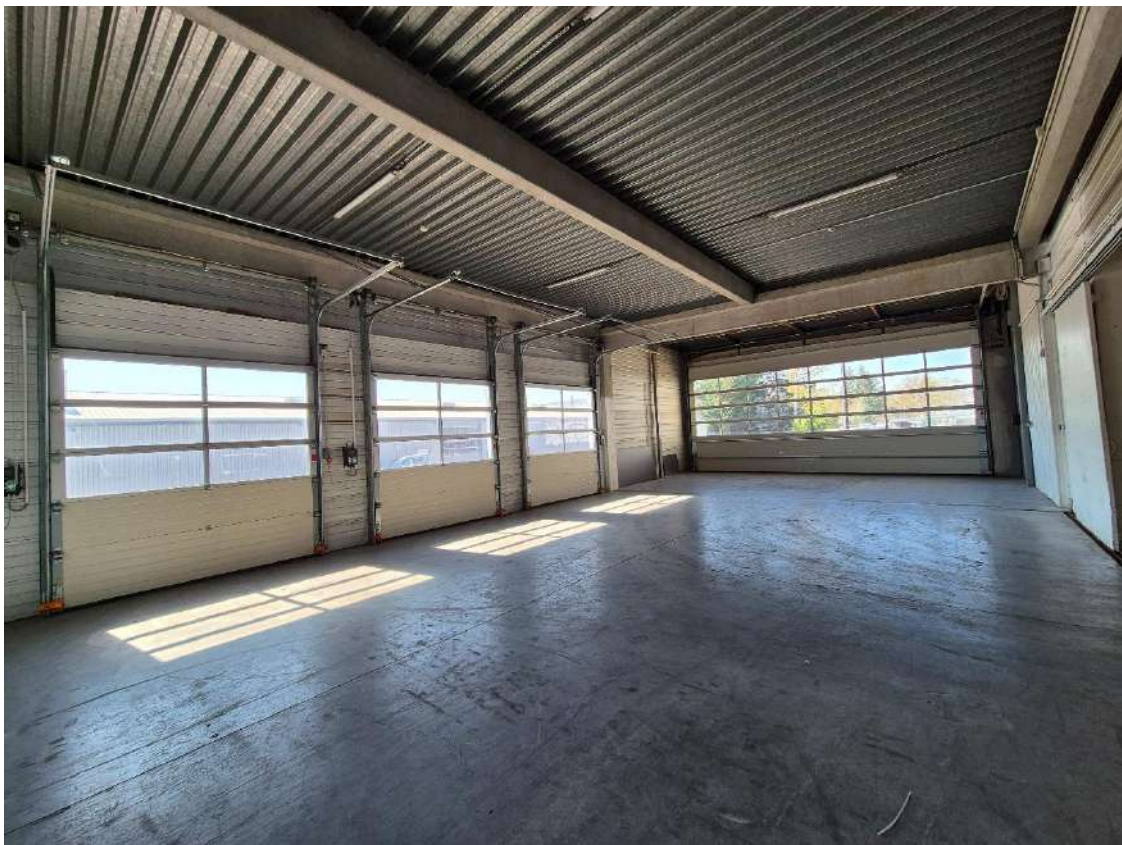
Figure 13: Lot 8 / Partie quai de chargement avec 1 accès de plain-pied et 3 quais pour poids lourds
