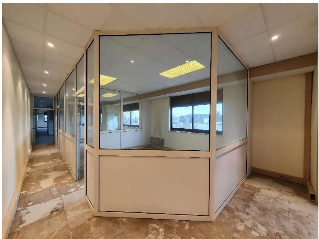
Figure 6: Lot 7 / Bureaux et sanitaires à aménager
