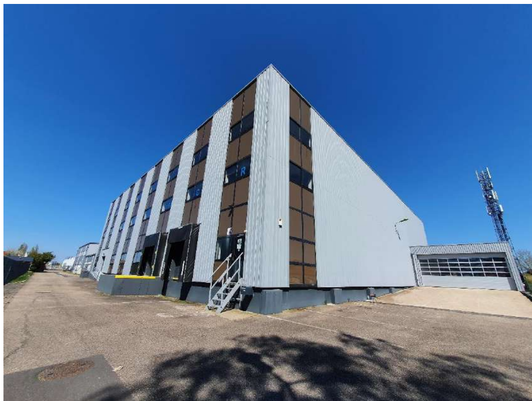
Figure 7: Lot 8 / Accès bureaux et dépôt avec rampe
