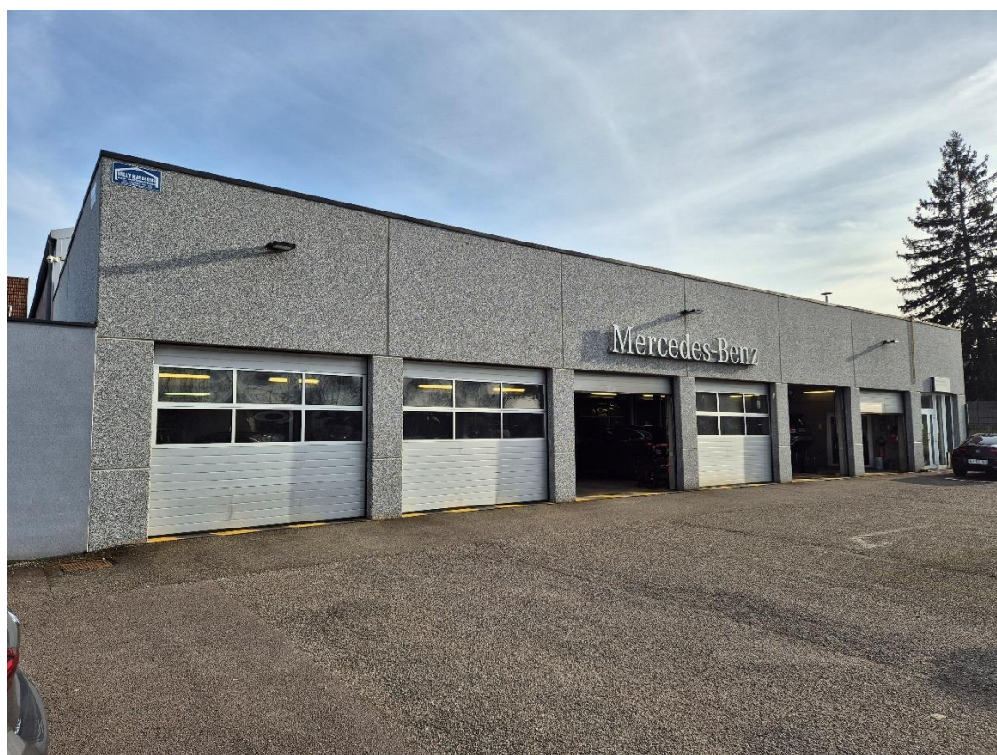
Figure 6: Face NORD-OUEST / Ateliers mécanique + parking client
