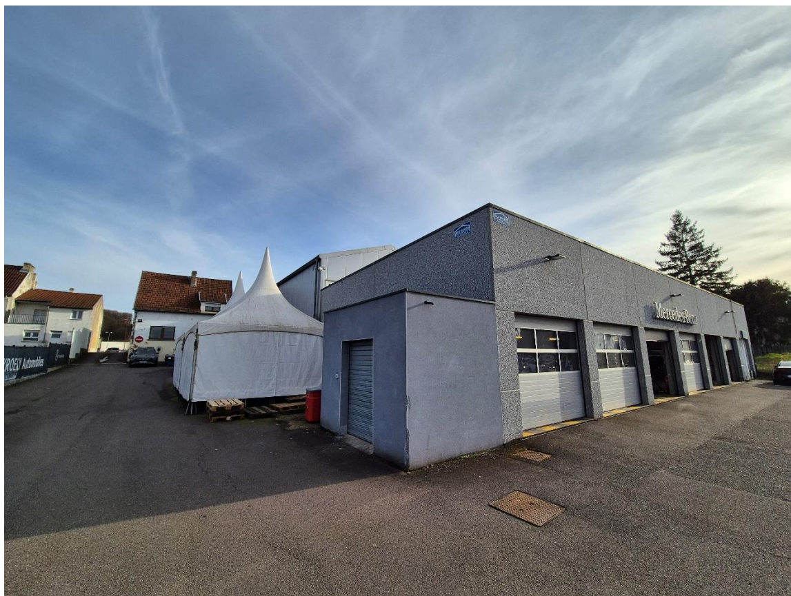
Figure 9: Face NORD-OUEST / Ateliers mécanique + voie pour circuler vers l'avant du site
