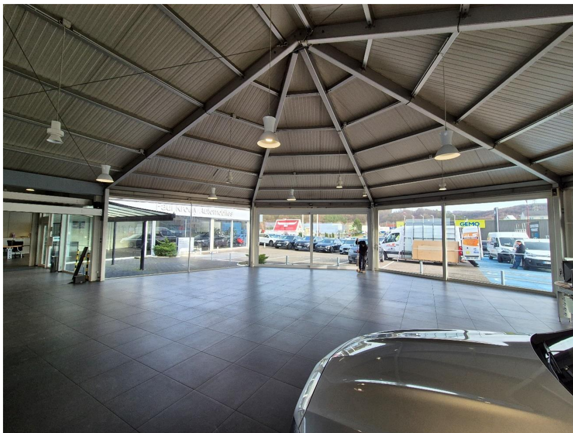
Figure 11: Entrée Showroom et Vitrine commerciale
