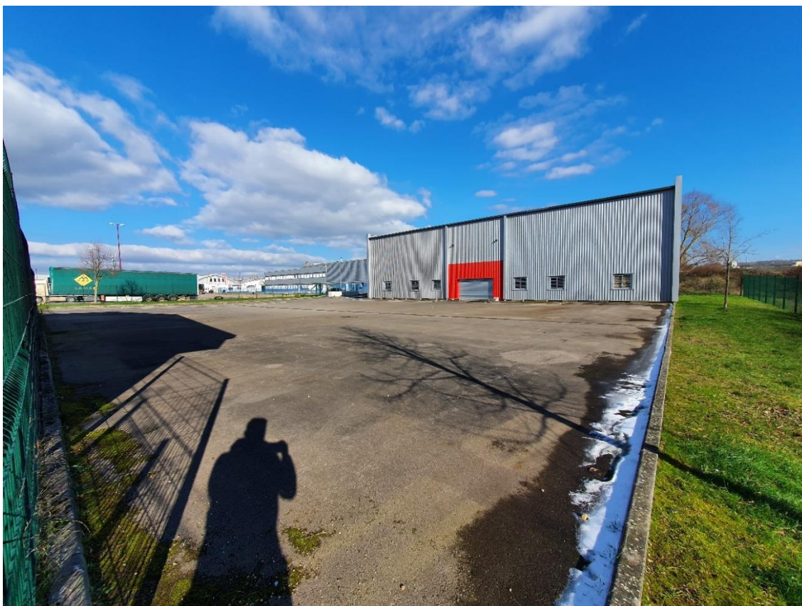
Figure 5 : Face OUEST / Accès bureaux + stockage macadamisé extérieur
