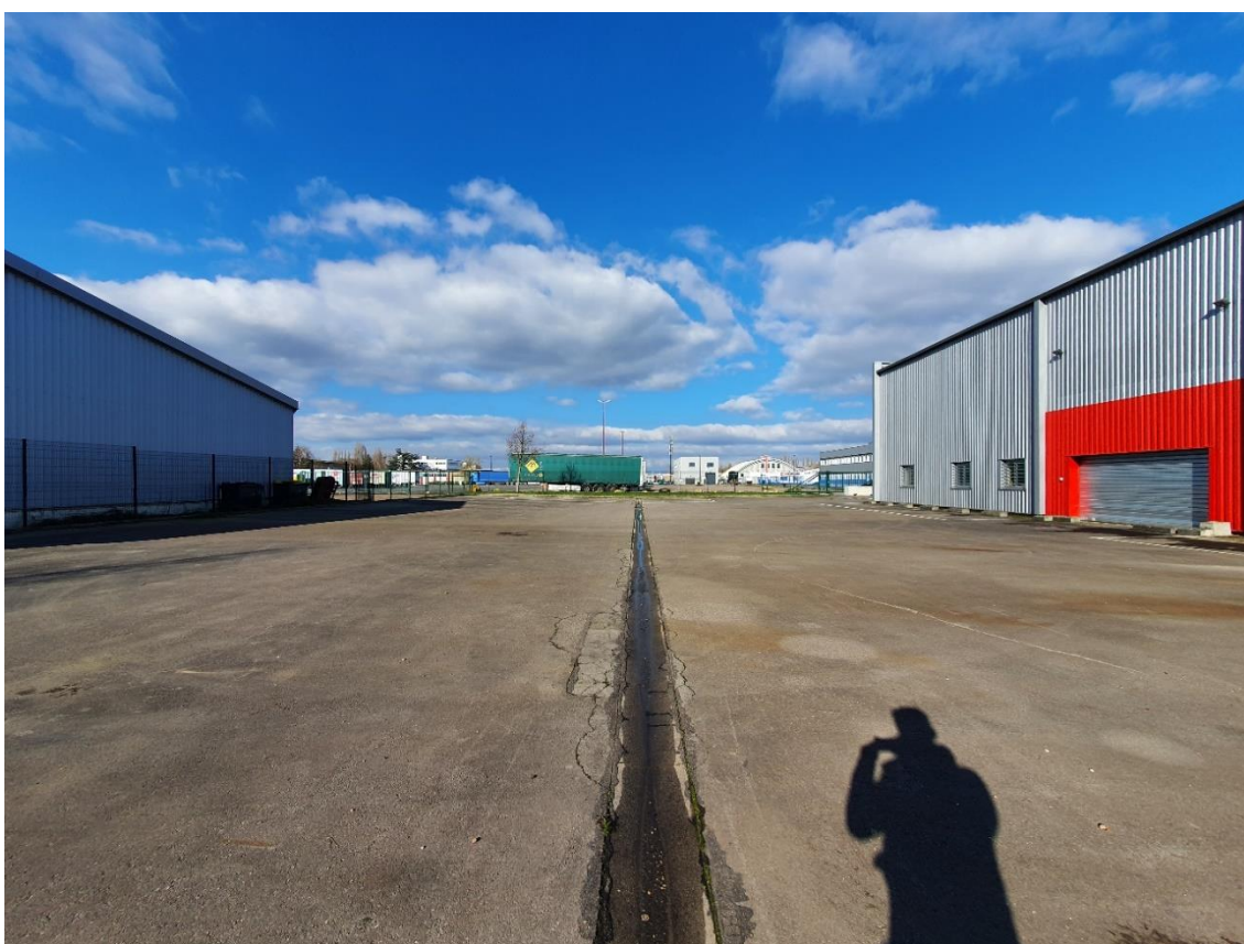
Figure 6 : Face OUEST / Accès bureaux + stockage macadamisé extérieur
