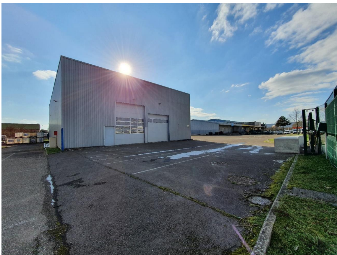
Figure 4: Face NORD / Accès dépôt + Portail d'accès
