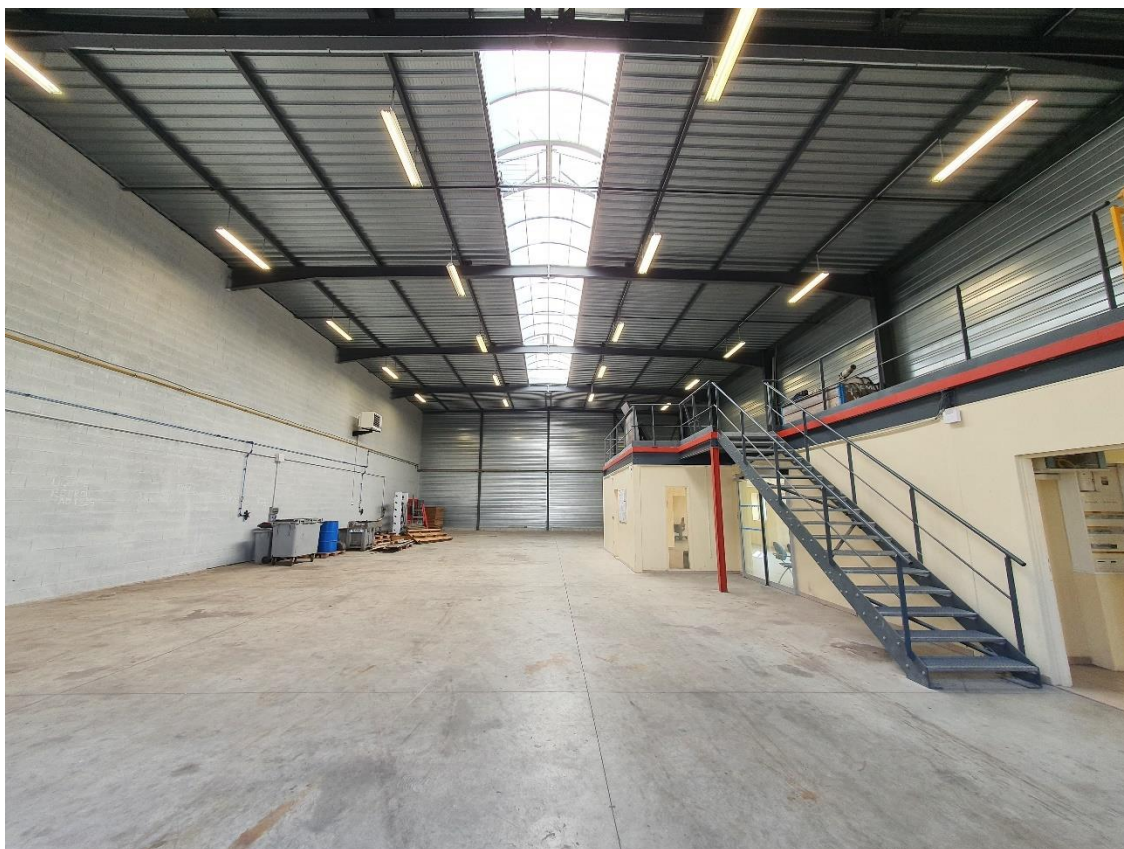
Figure 7: Partie EST / Atelier + Accès Mezzanine / 30m x ≈14m ≈ 430m 2
