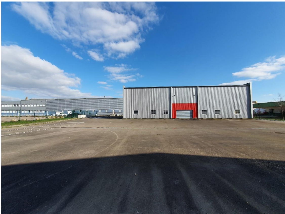
Figure 3: Face OUEST / Accès accueil et bureaux + parking
