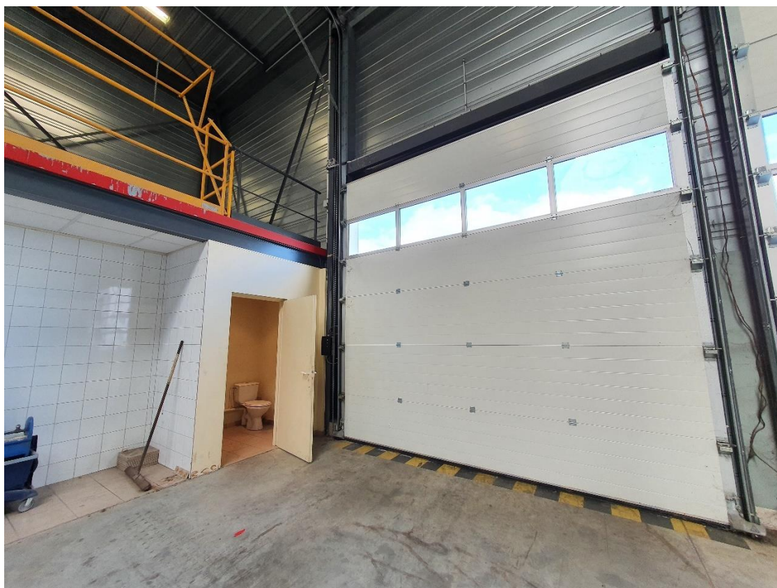
Figure 14: Partie EST / Porte sectionnelle automatique + sanitaire séparé
