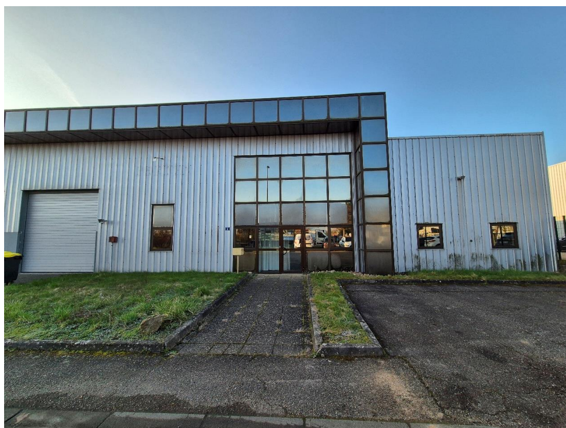
Figure 2 : Face Nord / Accès dépôt + parking macadamisé
