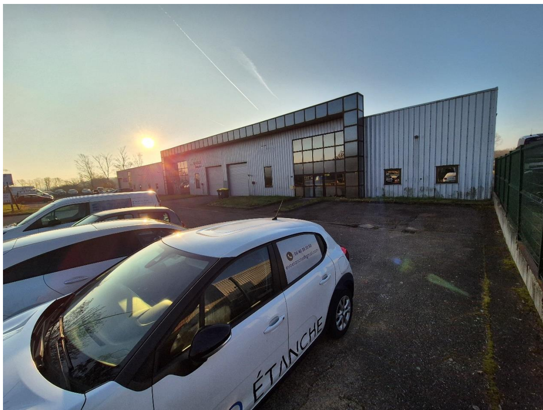
Figure 1 : Face Nord / Accès bureau et dépôt + parking macadamisé
