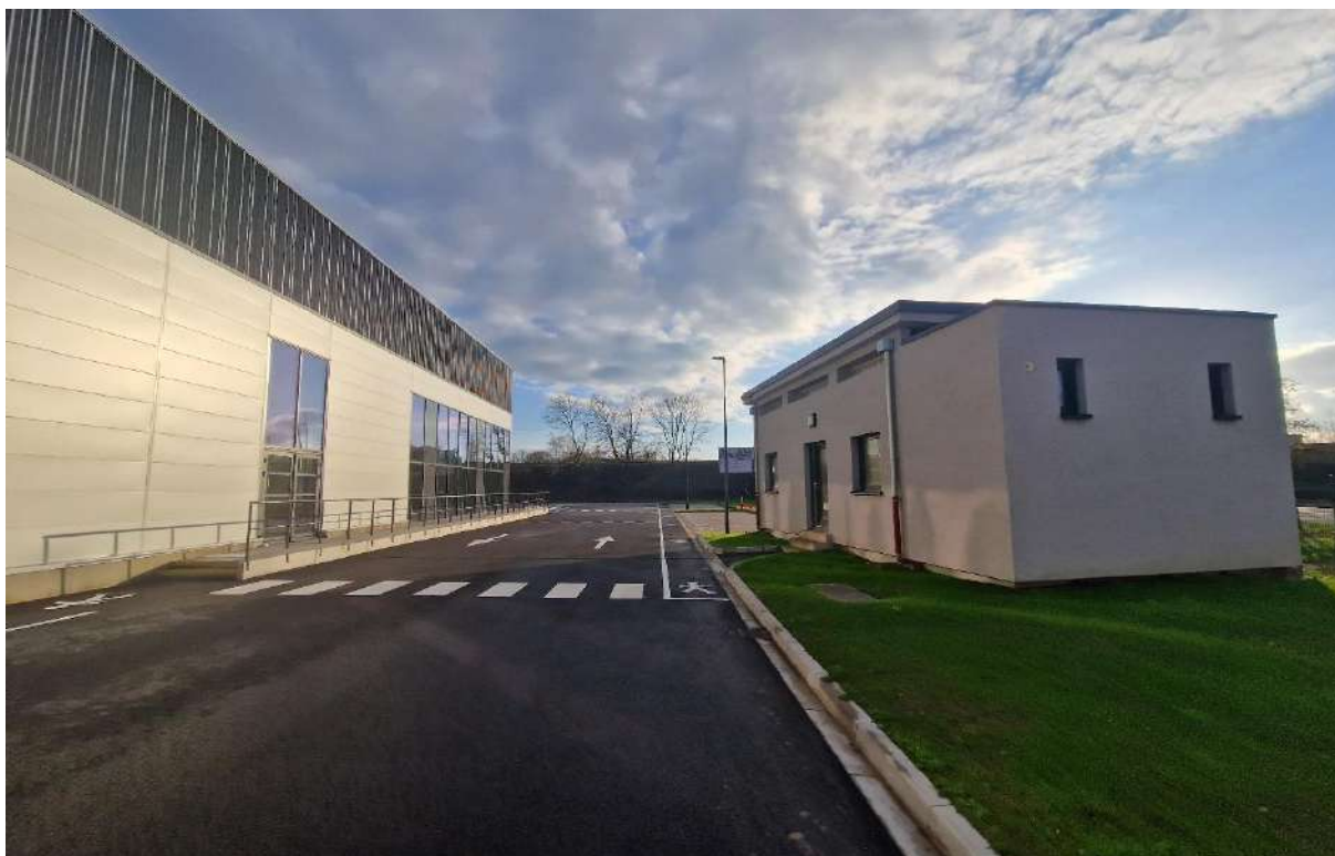
Figure 11 : Façade Ouest / Entrée du site
