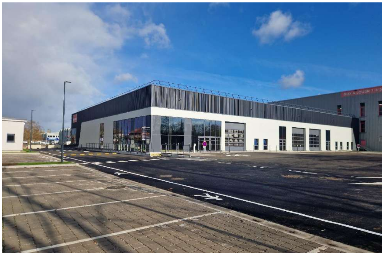
Figure 5 : Angle Sud-Ouest / Cellule commerciale 800m 2
