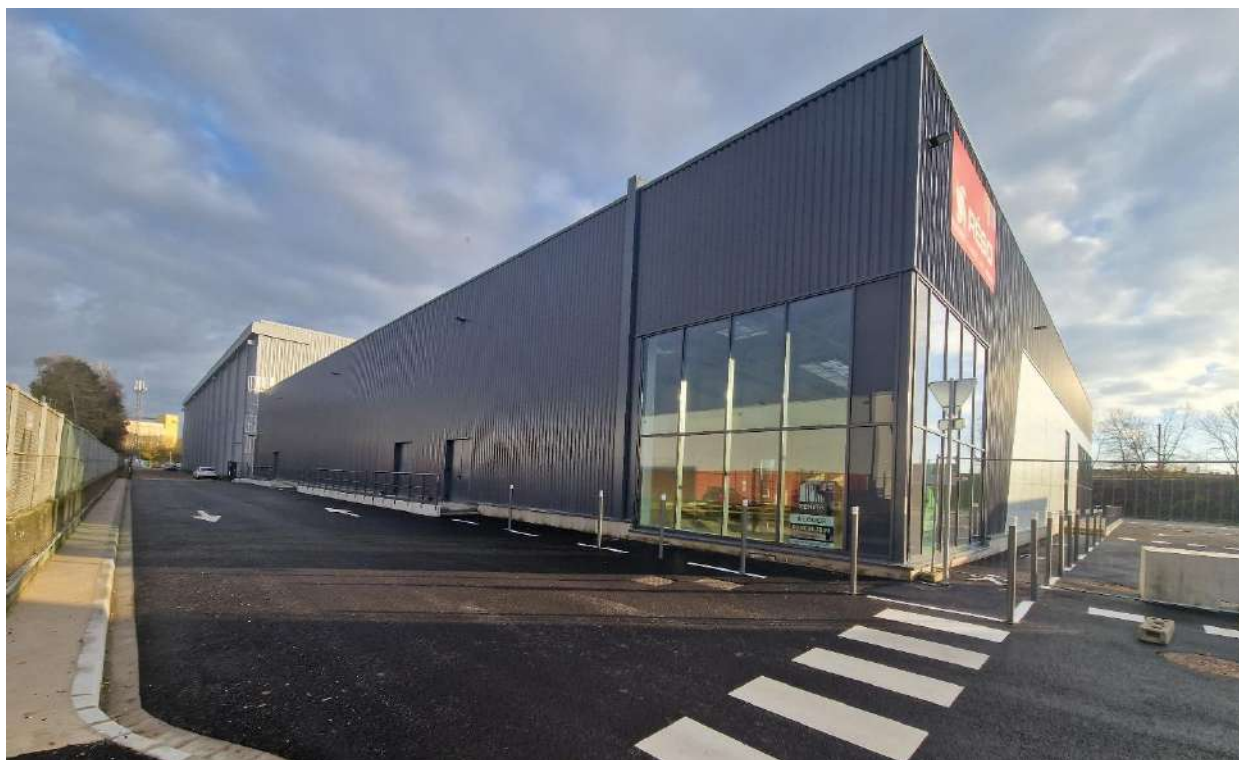
Figure 9 : Angle Nord-Ouest / Cellule commerciale 800m 2
