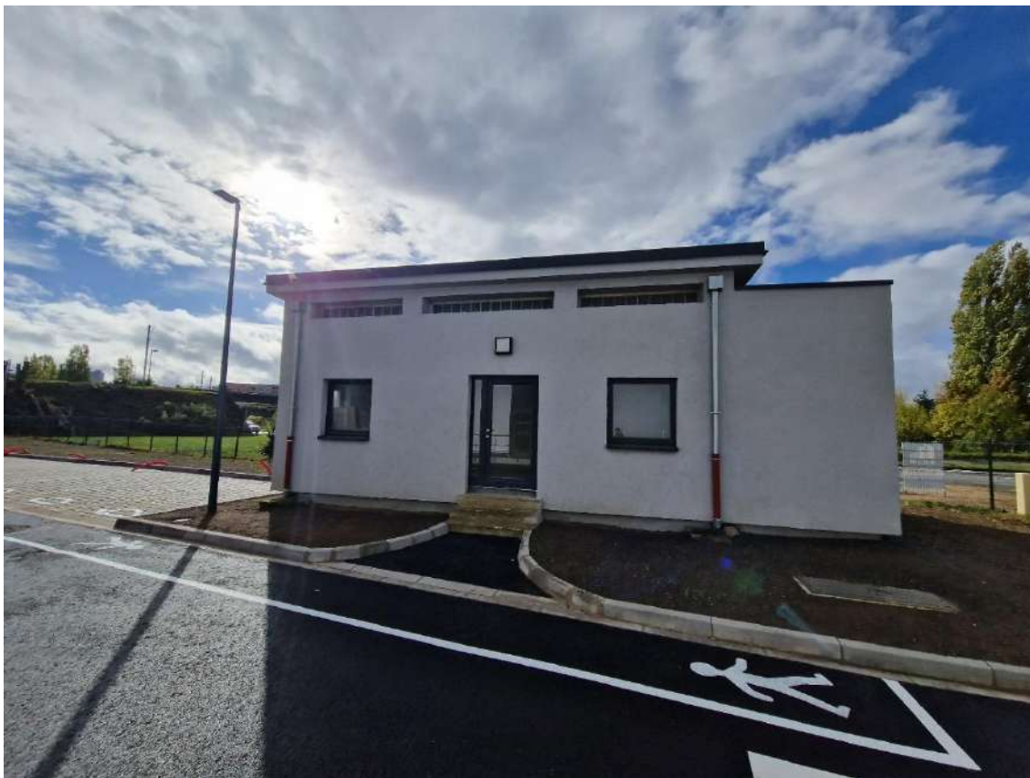
Figure 17: Partie extérieure / Surface complémentaire de 50m 2 de bureaux refaits à neuf
