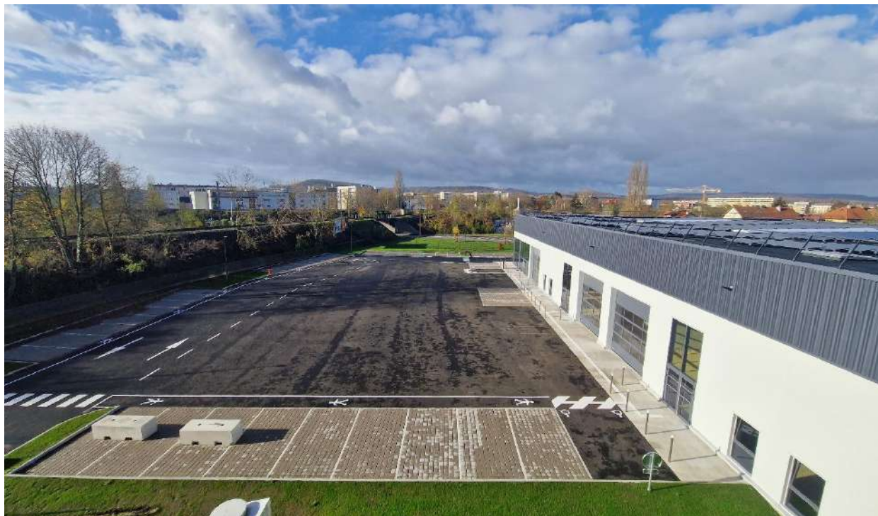
Figure 7 : Vue d'ensemble du parking et de l'aire de circulation
