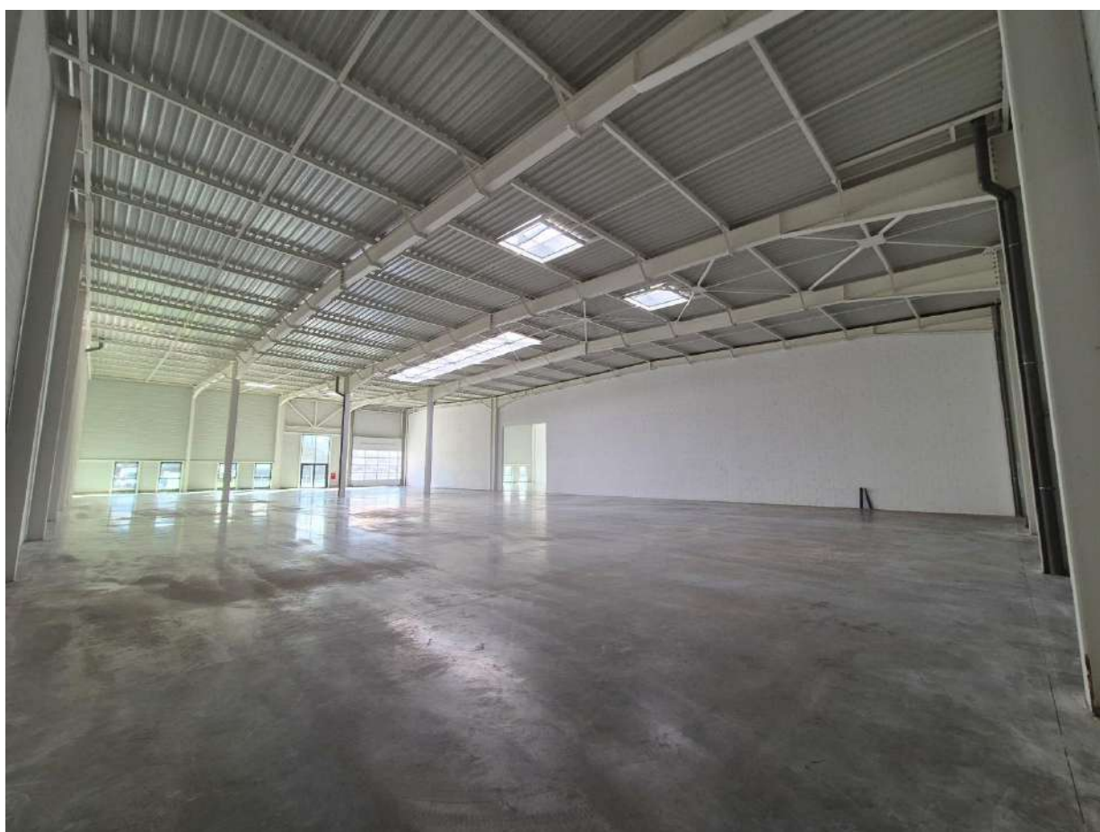
Figure 16: Partie intérieure avec dalle en béton quartzée / Cellule activité 1 000m 2
