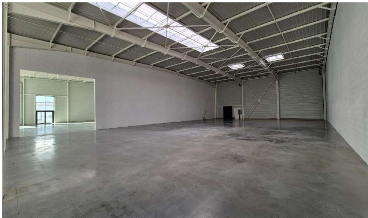
Figure 15 : Partie intérieure avec dalle en béton quartzée / Cellule activité 800m 2
