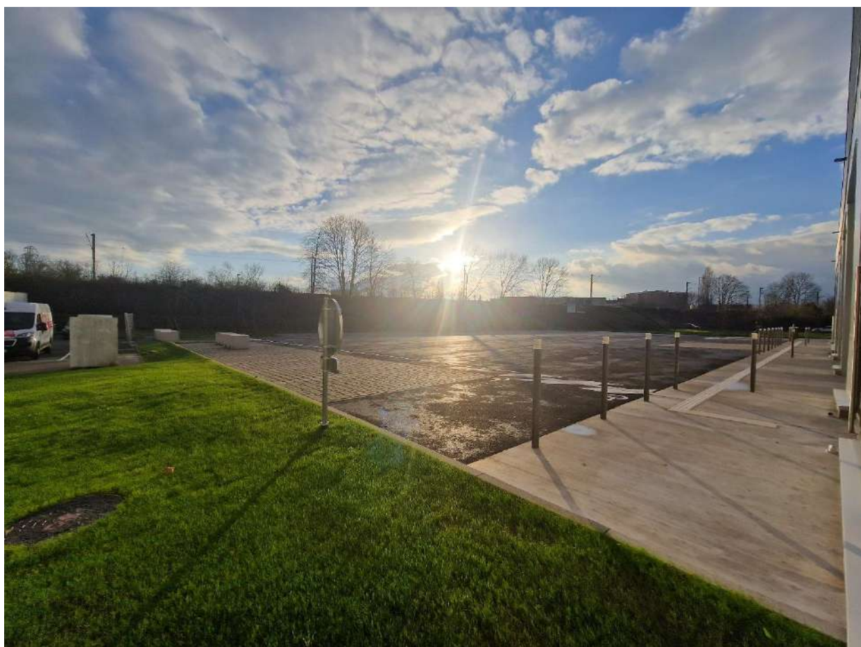
Figure 8 : Vue d'ensemble du parking et de l'aire de circulation
