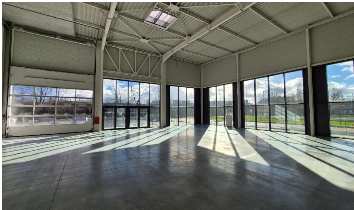
Figure 13 : Partie intérieure avec dalle en béton quartzée / Cellule commerciale 800m 2
