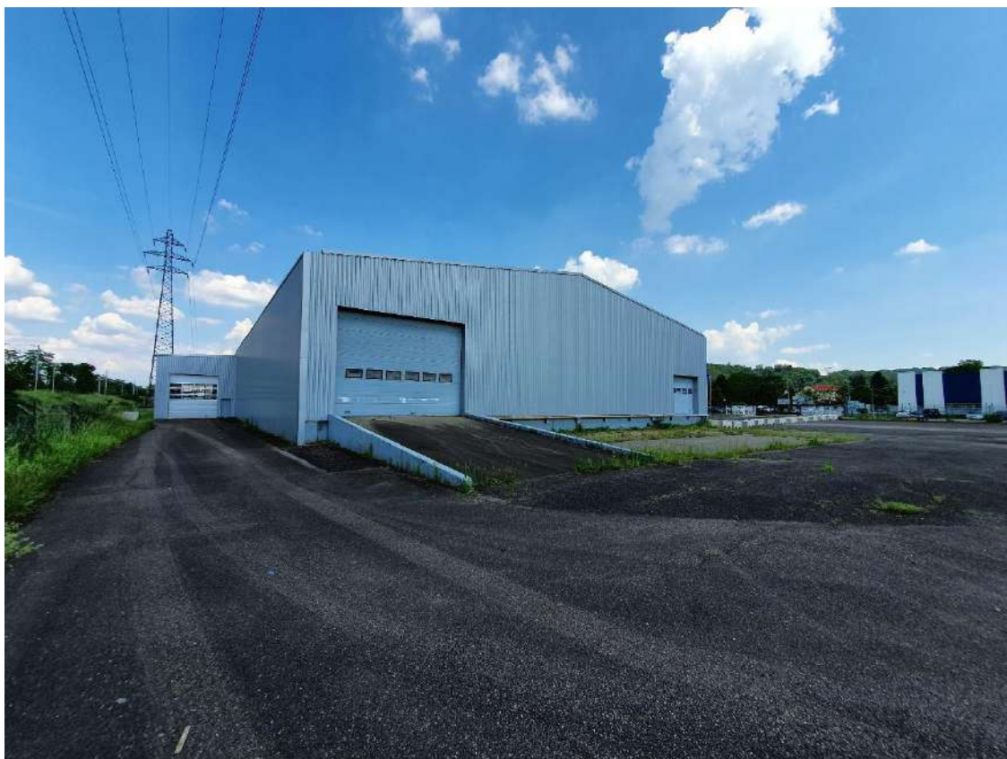
Figure 21 : Lot 3 / Angle NORD OUEST / Rampe d'accès au dépôt de et espaces extérieurs avec accès dépôt lot 4
