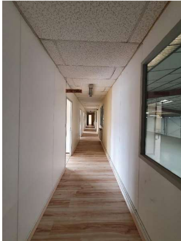
Figure 19: Lot 3 / Partie OUEST / Bureaux et sanitaires au-dessus des dépôts
