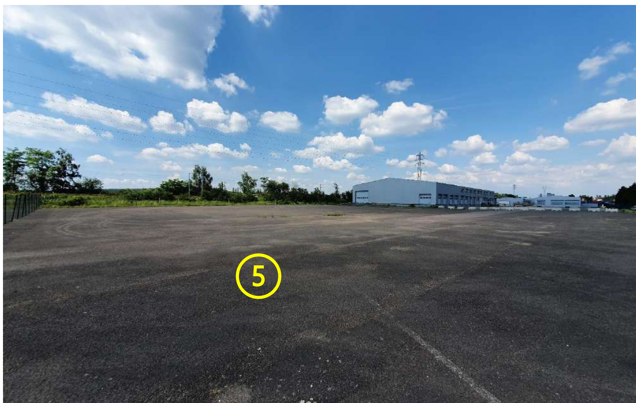
Figure 8 : Lot 5 / Angle SUD OUEST / stockage extérieur macadamisé
