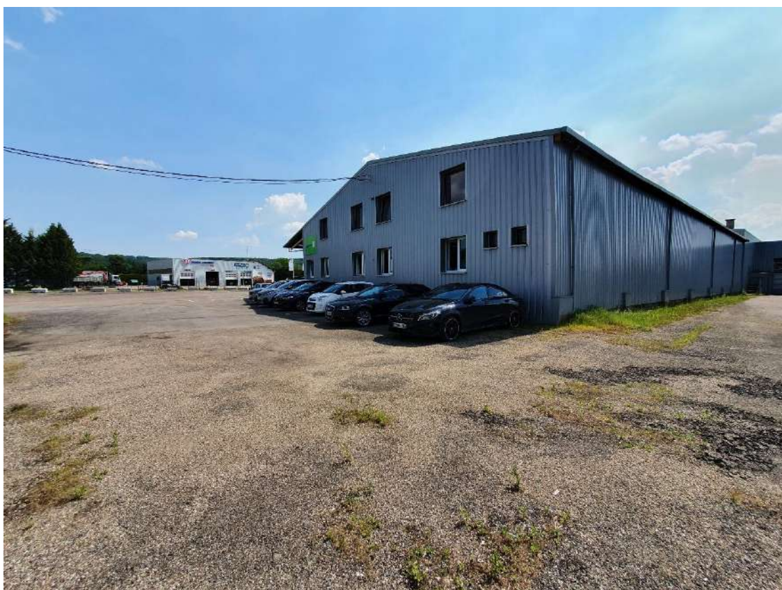
Figure 22 : Lot 1 / Angle NORD EST / Bâtiment administratif et espaces extérieurs avec accès dépôt lot 4
