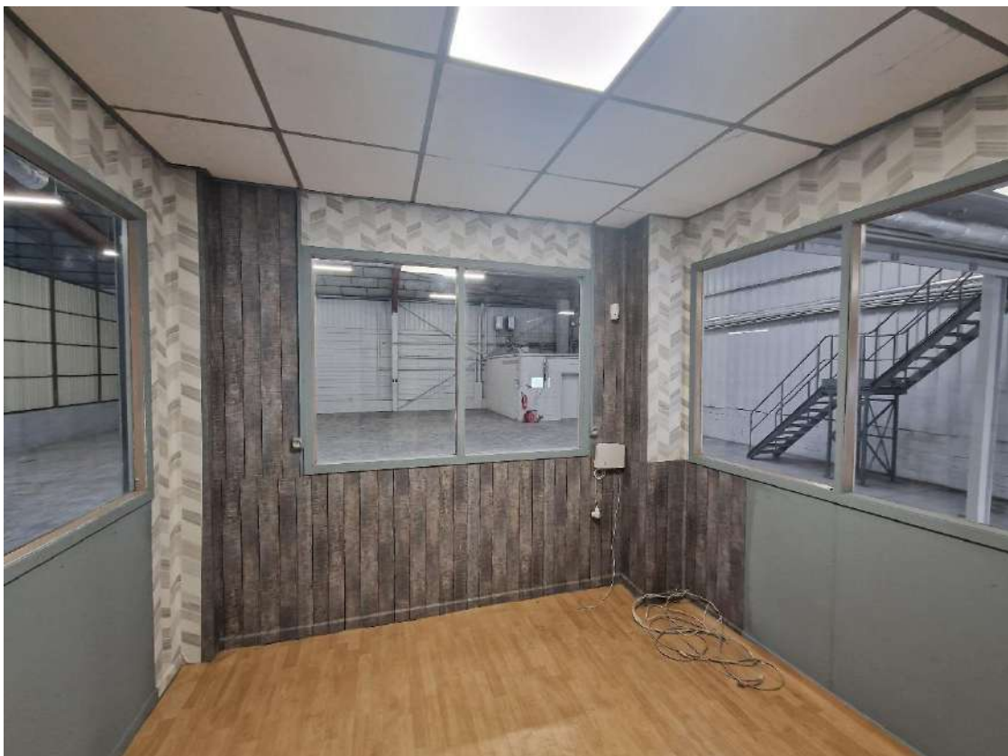
Figure 20: Lot 3 / Partie OUEST / Bureaux et sanitaires dans le dépôt
