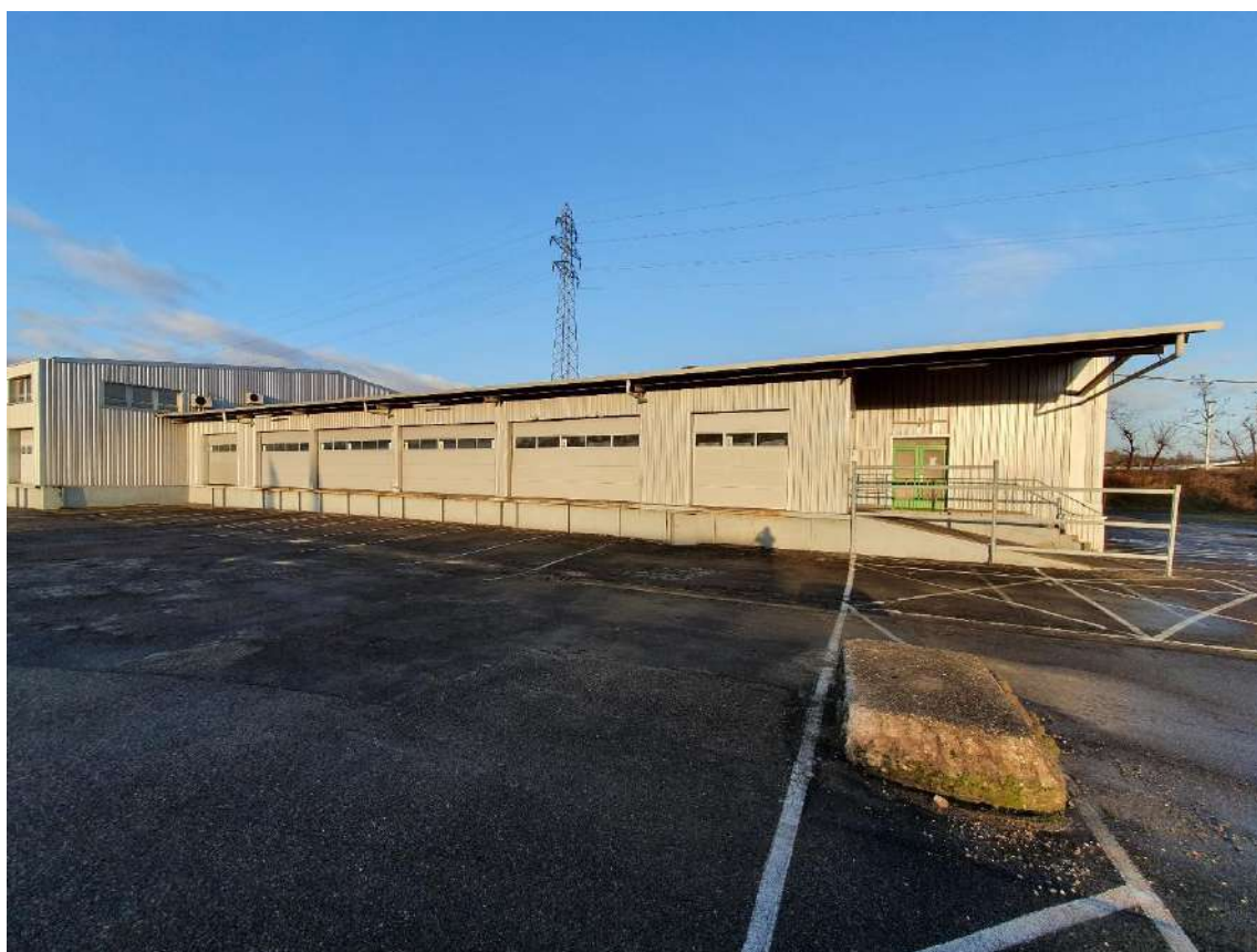
Figure 6: Lot 1 / Face SUD / Dépôt avec 6 quais + 1 rampe d'accès + Bâtiment administratif à droite
