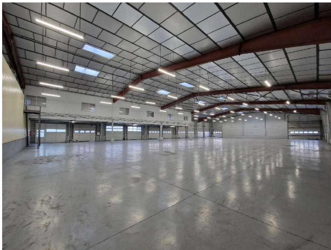
Figure 15: Lot 3 / Partie OUEST / Dépôt avec 13 portes sectionnelles automatiques + rampe d'accès / 60m x 25m
