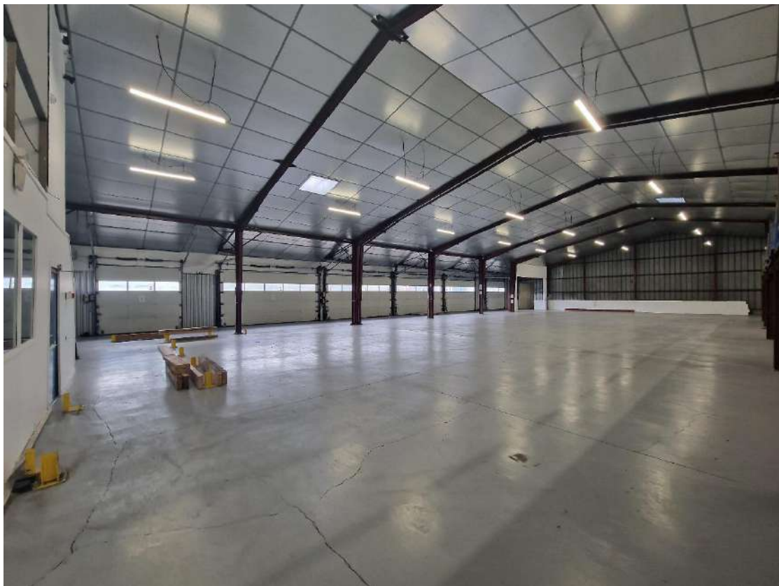
Figure 9: Lot 1 / Partie EST / Dépôt avec 6 Quais et 1 rampe d'accès / 36m x 25m ≈ 880m 2
