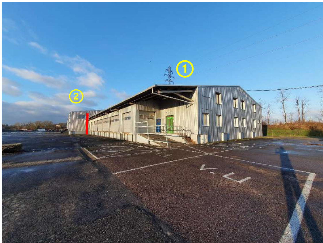
Figure 5: Lot 1 / Face SUD / Dépôt avec 6 quais + 1 rampe d'accès + Bâtiment administratif à droite
