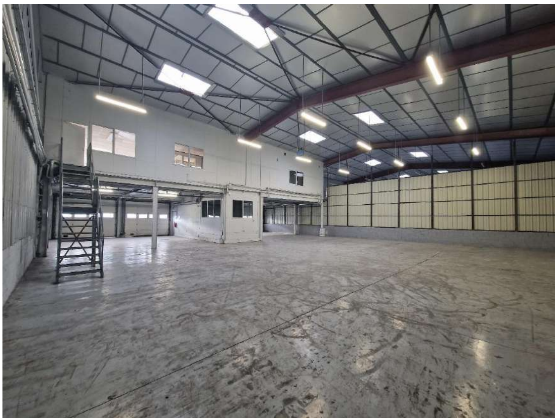
Figure 13: Lot 2 / Partie CENTRALE / Dépôt avec 4 quais + locaux sociaux à l'étage / 24m x 25m
