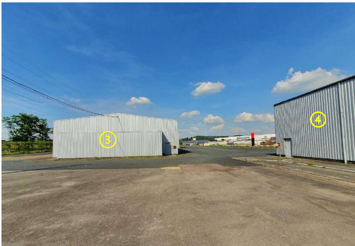
Figure 21 : Lots 3 et 4 / Partie OUEST / Stockage macadamisé jouxtant le dépôt du lot 4
