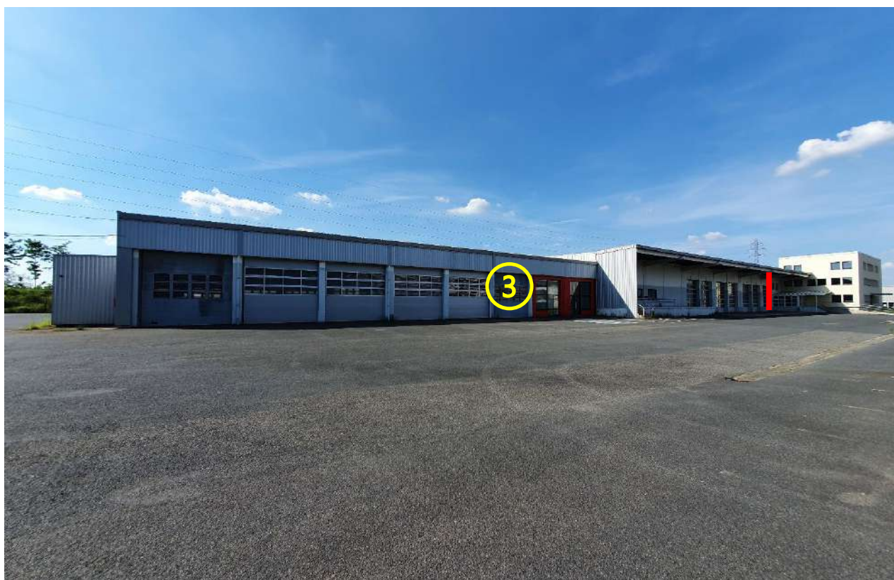
Figure 8: Lot 3 / Face SUD / Dépôt avec portes sectionnelles à gauche + petite partie administrative
