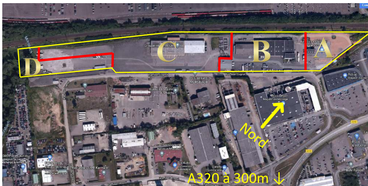
Figure 3: Vue Satellite / Site en 2019 / \approx 700m \times \approx 75m \approx 50\,056m^2 (A,B,C,D)
