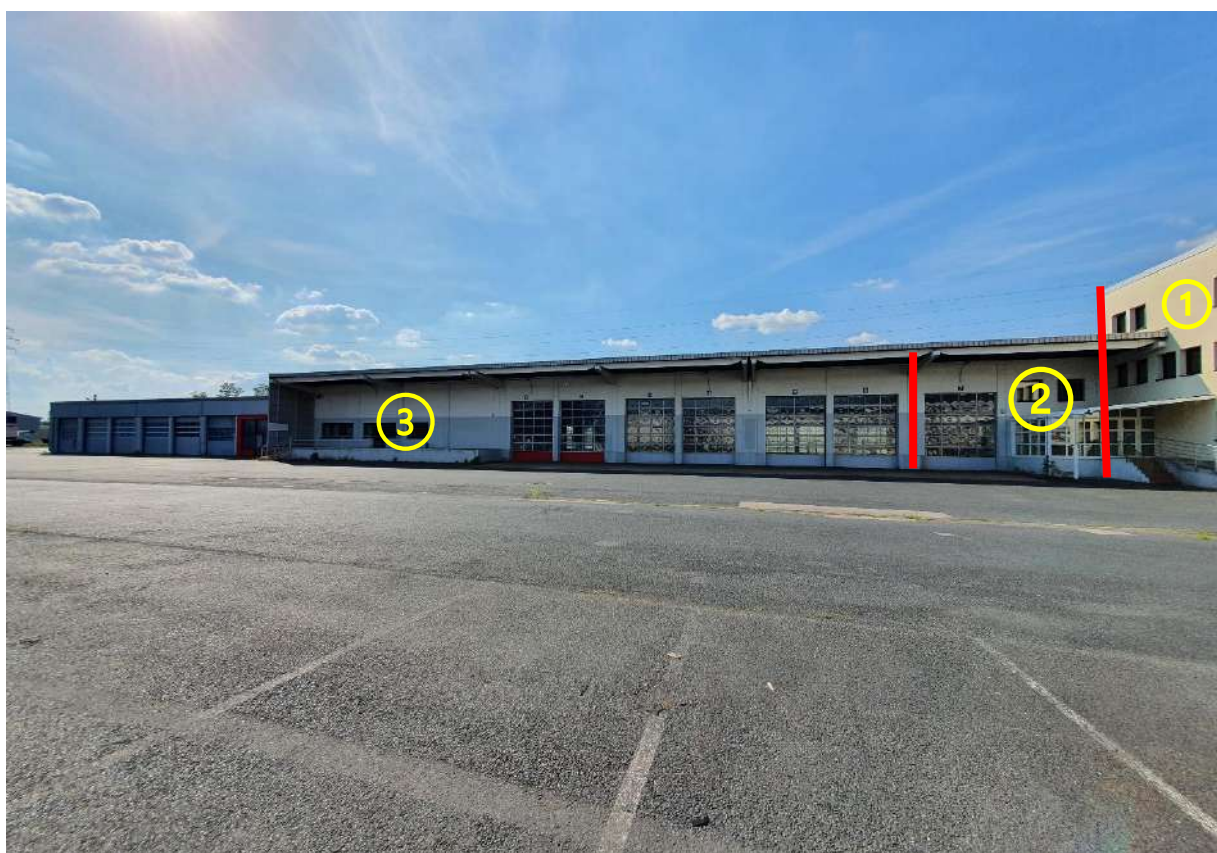
Figure 6: Lots 2 et 3 / Face SUD / Dépôt avec portes sectionnelles automatiques traversantes
