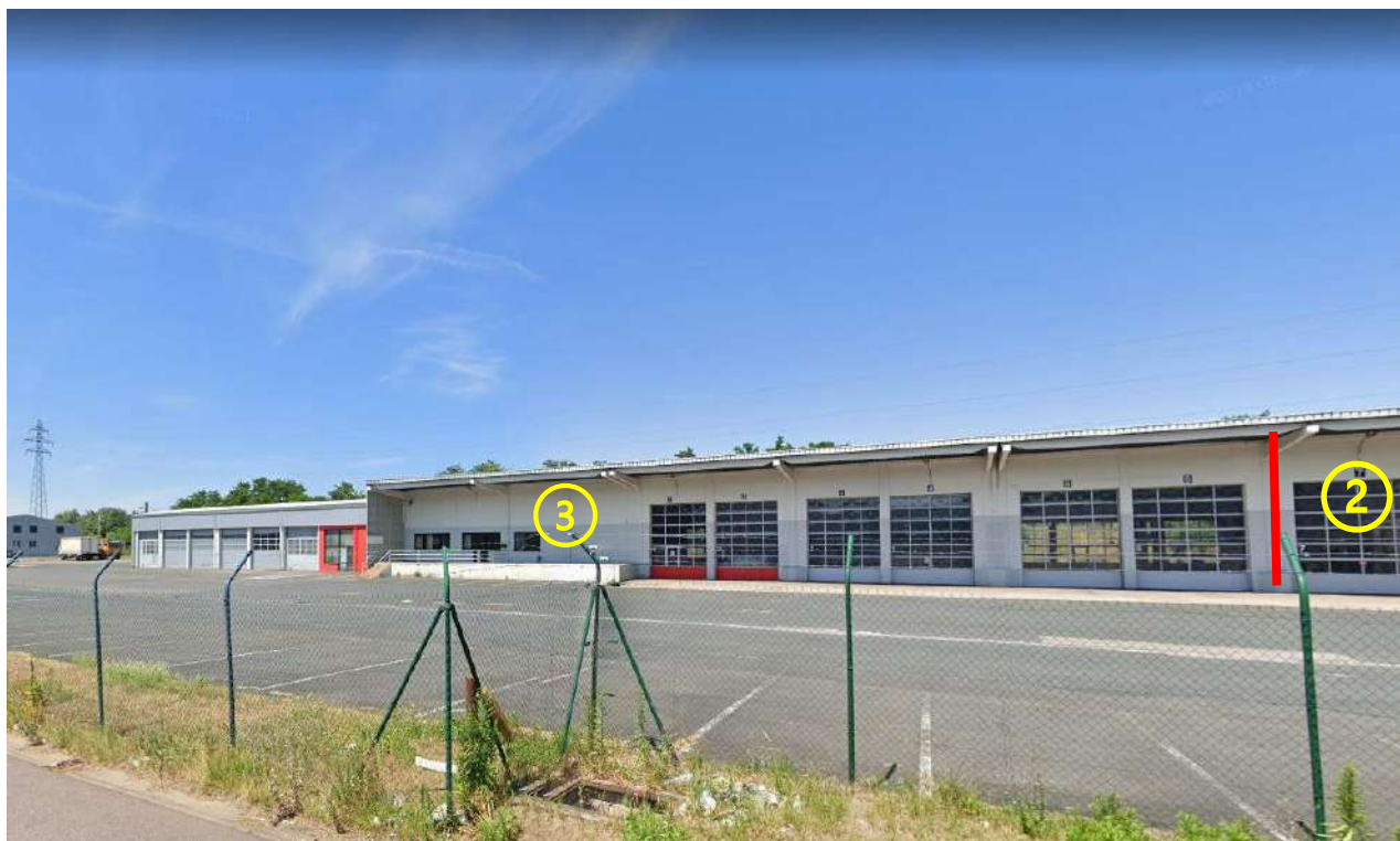
Figure 7: Lots 2 et 3 / Face SUD / Dépôt à gauche + Dépôt à droite
