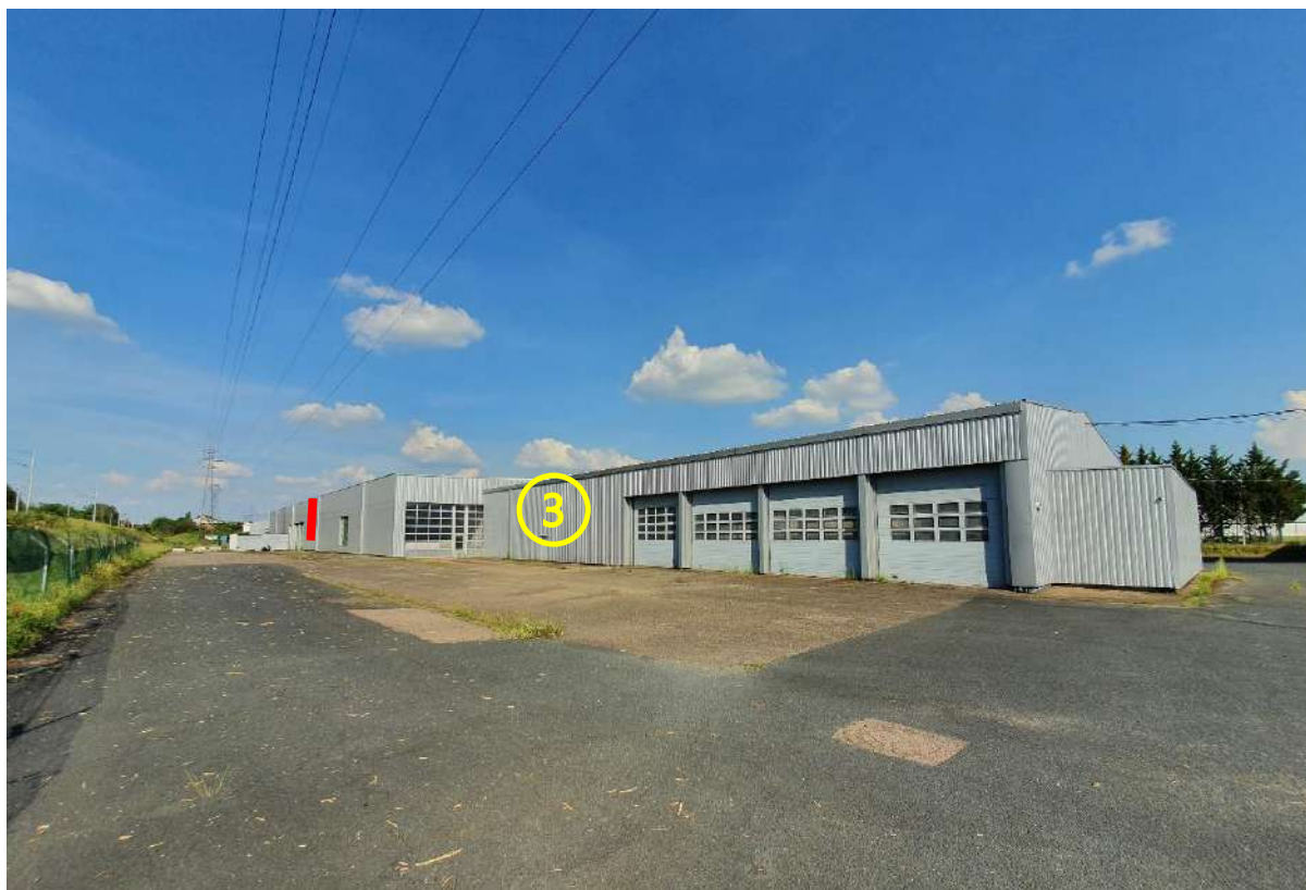
Figure 9: Lot 3 / Angle NORD-OUEST / Dépôt + stockage macadamisé
